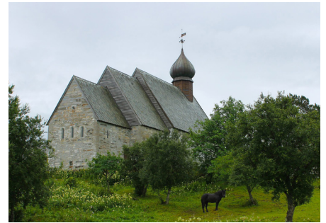
Kystriksveien. Photo: Silje Lindberg
